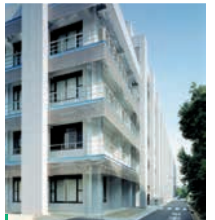
大阪大学基礎工学部本館 ＜大阪府＞
