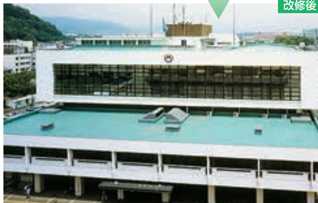
機械的固定工法による 改修施工例
