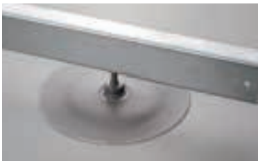
防水層とは溶剤溶着または、熱風融着で接合。 強力な水密性を発揮します。
