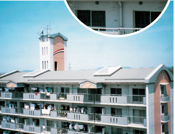
ロンライン施工例
