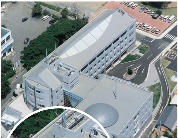
ロンライン施工例
