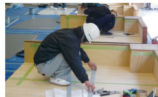
施工台を使用しての施工指導
