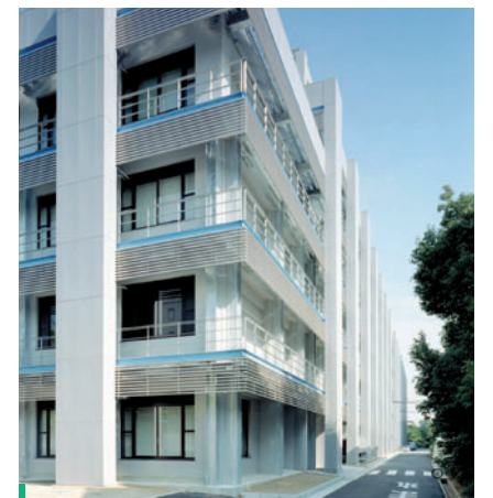
大阪大学基礎工学部本館 ＜大阪府＞
