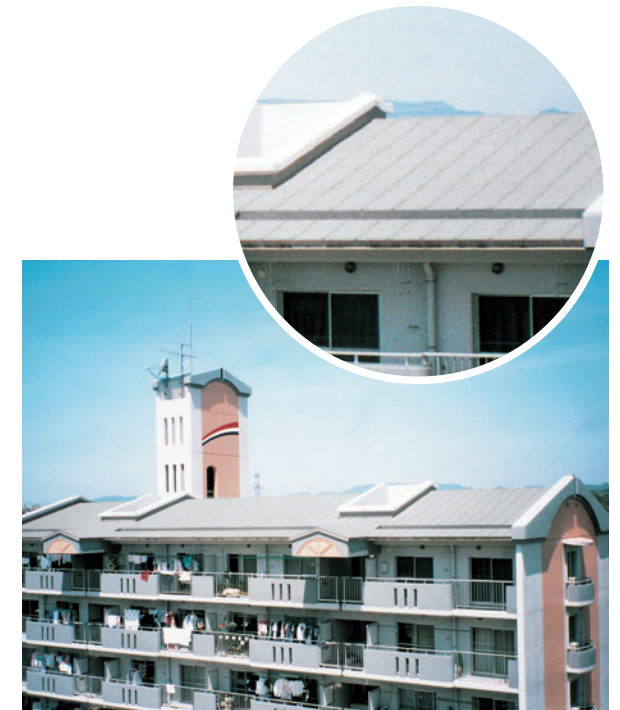
ロンライン施工例
