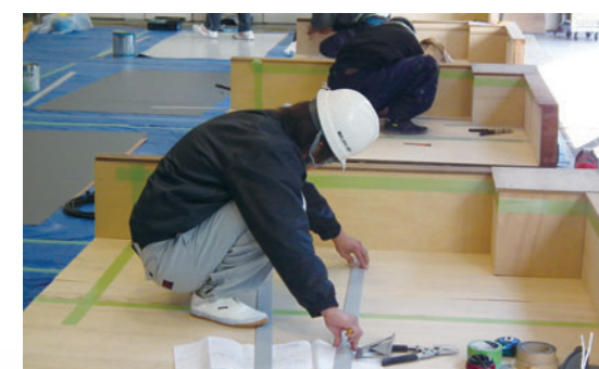
施工台を使用している施工指導
