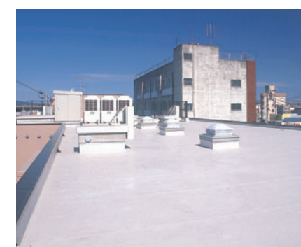
ベストブルーフシャネツ防水仕様の施工例
