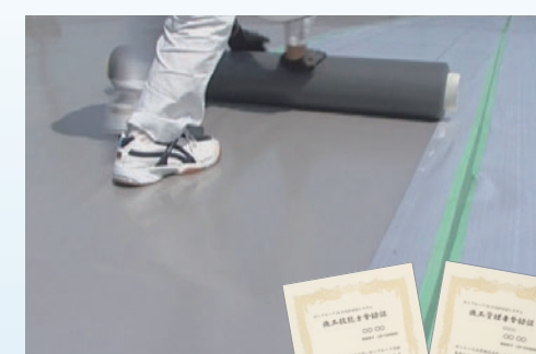
シート防水施工風景
