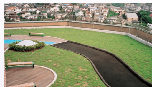
屋上緑化(ロングリーン仕様)の施工例
