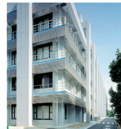
大阪大学基礎工学部本館 ＜大阪府＞
