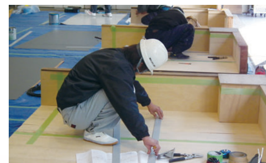
施工台を使用している施工指導
