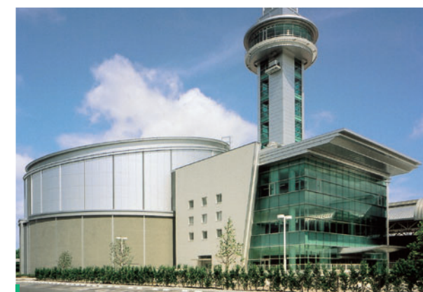
芦屋競艇場施設 ＜福岡県＞
