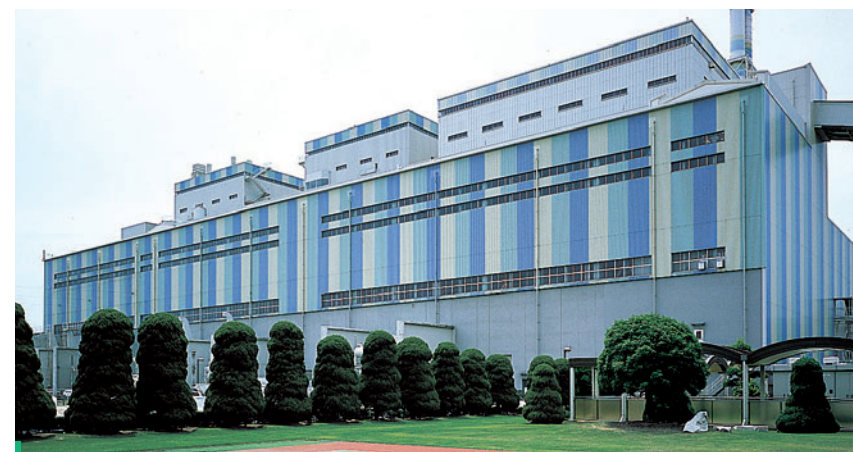
中国電力 火力技術開発センター ＜山口県＞
