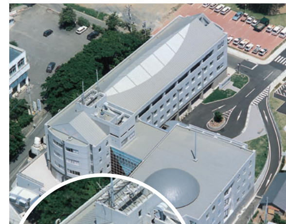
ロンライン施工例
