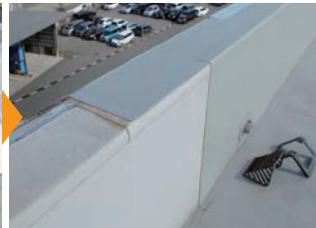
▲パラベットも既存シートの上に平滑に接着工法で施工した
